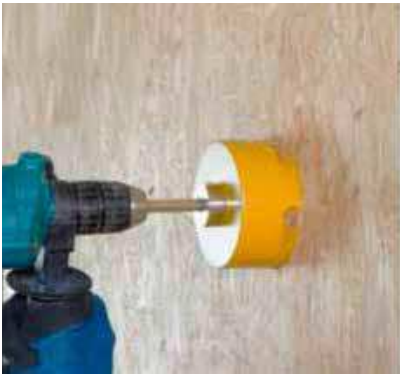
Perçage d'une ouverture circulaire
